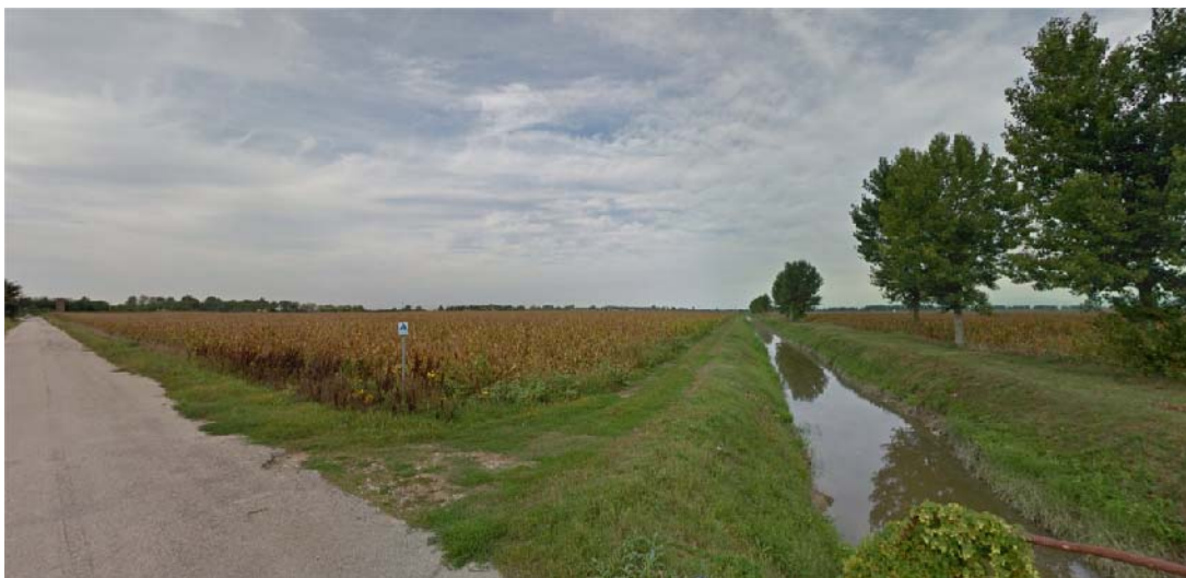
Figura 7 – Vista n. 4 da nord-est in direzione sud-ovest, punto di innesto sulla nuova viabilità nord
