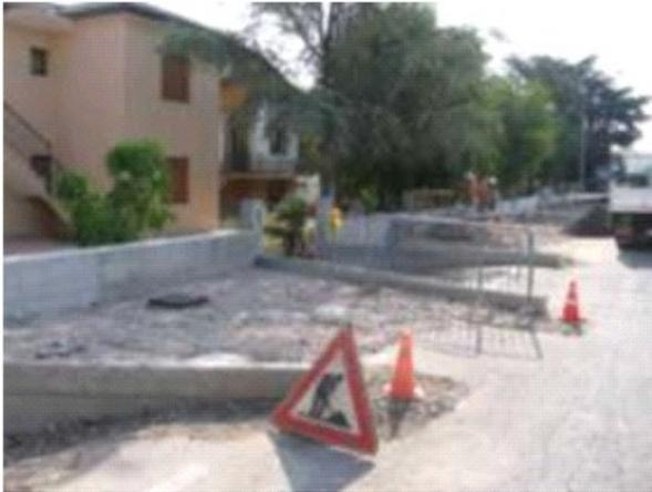
L'intervento ha previsto la sistemazione della Via Garibaldi, mediante la razionalizzazione degli spazi per la formazione di stalli di sosta, di percorsi pedonali e ciclabili. L'opera ha previsto la formazione di una nuova linea della pubblica illuminazione e la revisione della linea di raccolta delle acque meteoriche.
